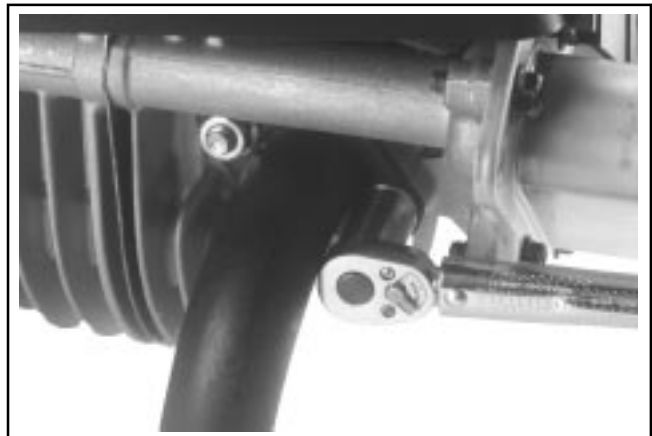
Figure 10-78. Serrage des écrous du système d'échappement.
