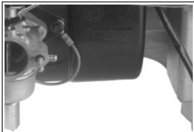
Figure 10-56. Mise en place du conducteur de masse.
