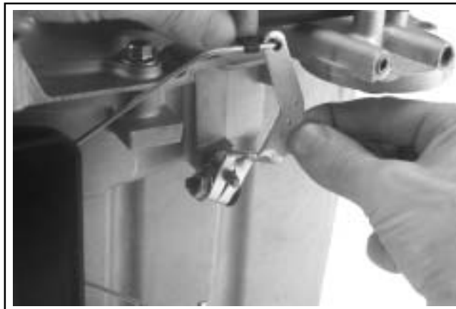
Figura 10-63. Palanca del regulador instalada en el eje.
