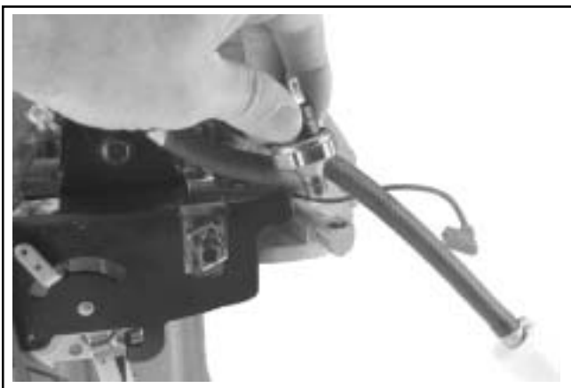
Figura 8-2. Desmontaje del interruptor Oil Sentry™.
